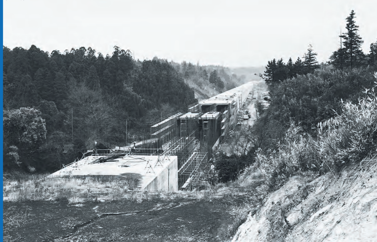
いずみ野線の建設工事 (1974年)
